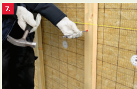
7. Steek de schroef in de muur.
