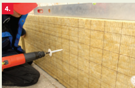
4. Bevestig de isolatie met 2 pluggen per plaat.
