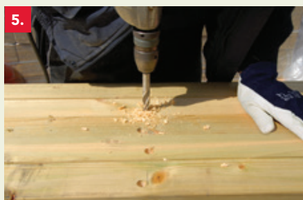
5. Boor de houten regel voor.
