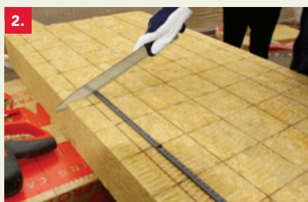
2. Snijd de ROCKWOOL isolatie op maat.
